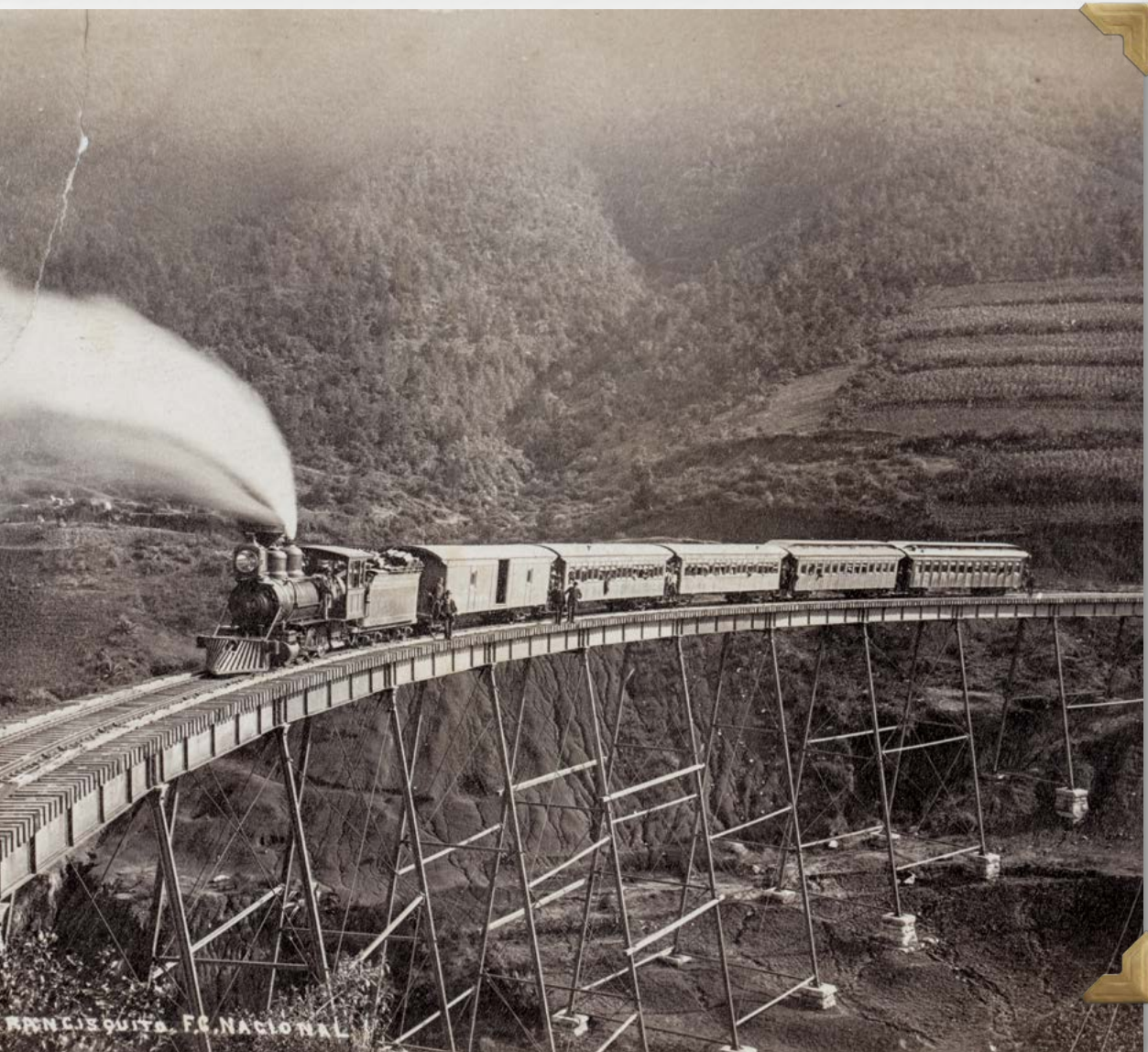
Gove & North Fotografía Americana (sociedad estadounidense activa en México entre 1870 y 1884) | Puente de San Francisquito Ferrocarril Nacional [Puebla, México] | Esta estructura fue una de las obras de ingeniería más icónicas. El puente combina tramos cortos independientes apoyados en torres de acero, las cuales estabilizan las barras angulares cruzadas o en celosía | Álbum: Colección de fotografías antiguas de Abel Briquet siglo XIX | c 1882-1884 | Impresión sobre papel albuminado, entonada y montada en cartón. Álbum: media encuadernación en piel y material de algodón con recubrimiento sintético para encuadernación, con puntas en piel | 11.2 x 19.3 x 0.017 cm; con soporte 29.3 x 23.1 x 0.05 cm | Fondo Guillermo Tovar de Teresa | Fotografía: Gisa Villanueva | 55154ck
